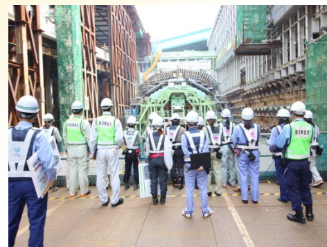
現場点検③
