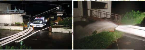
杣井木川から永野川へポンプ排水
