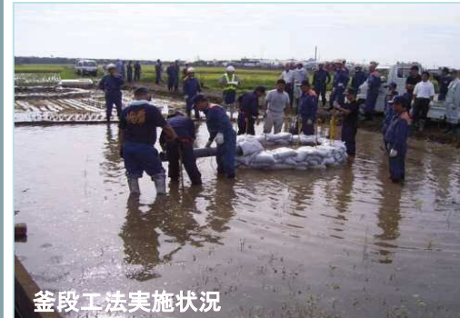
釜段工法実施状況
