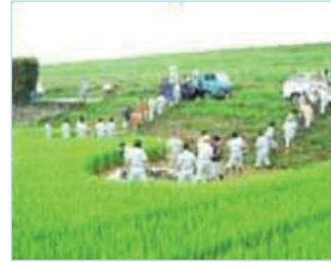
月の輪工法実施状況
