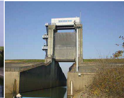
②第2排水門（幅10m×1門）
