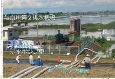
与良川から渡良瀬第2調節池(渡良瀬川)へ排水機場と共同してポンプ排水
