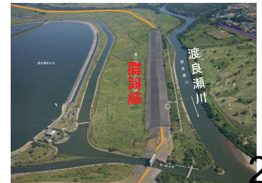
④第1越流堤[下流]（延長：1,400m）
