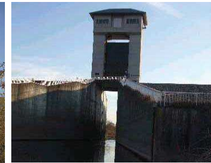
③第3排水門（幅6.5m×1門）
