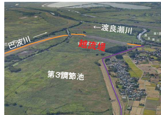
⑦第3越流堤（延長：496.5m）
