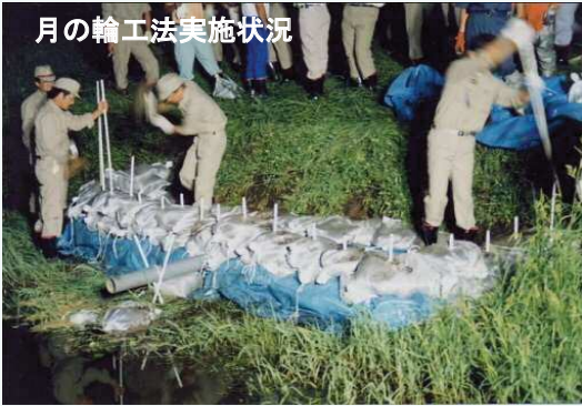
月の輪工法実施状況
