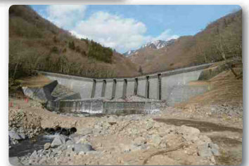
15 稲荷川第10上流砂防堰堤
