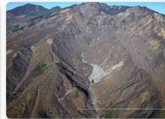
14 日向砂防堰堤
