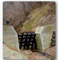
10 田茂沢第2砂防堰堤
