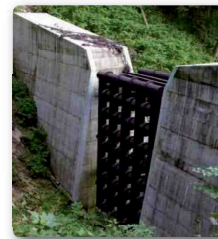
10 田茂沢第1砂防堰堤
