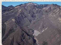
般若沢下流砂防堰堤完成
