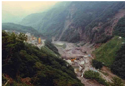
第2回目の嵩上げ工事中(昭和53年撮影)
