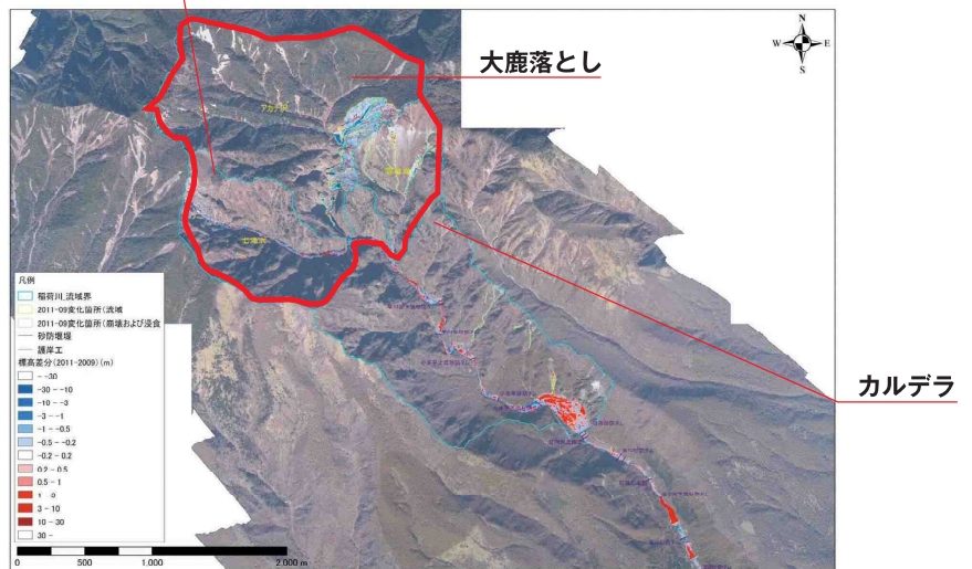
七滝沢崩壊地
