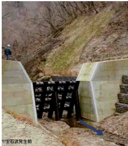
田茂沢第2砂防堰堤
