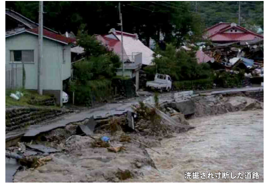
洗掘され寸断した道路
