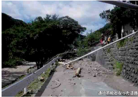
通行不能となった道路
