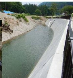
残存型枠による護岸工
