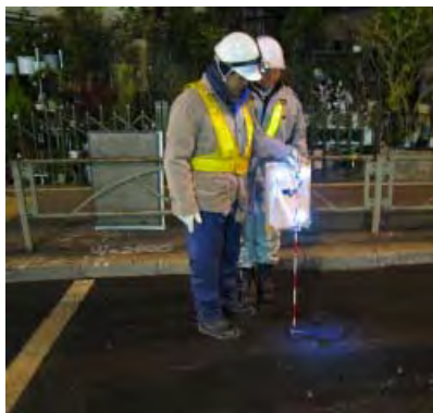
(a) 本線内へのプリズム設置状況
