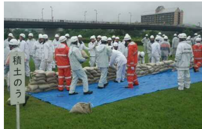
水防工法(積土のう)
