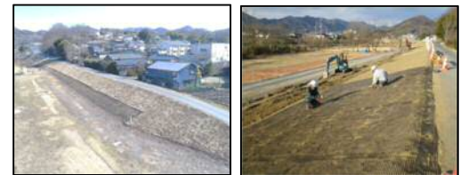
H29 桐生管内堤防法面補修他工事
