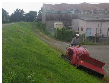
機械式除草実施状況
