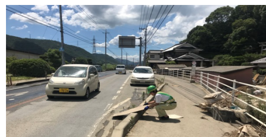
作業支障物撤去片付け
