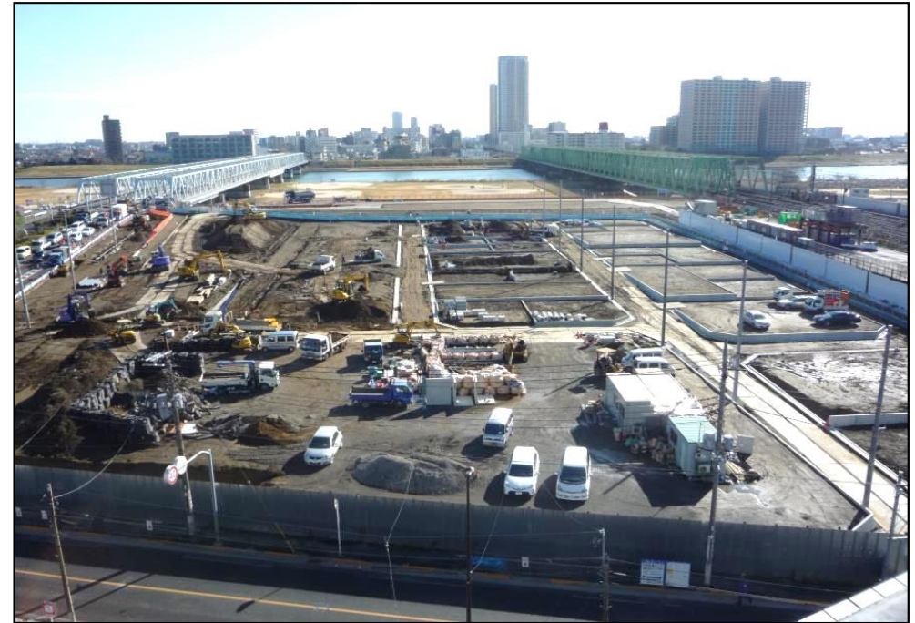
共同事業者の街区工事状況 （平成29年1月）
