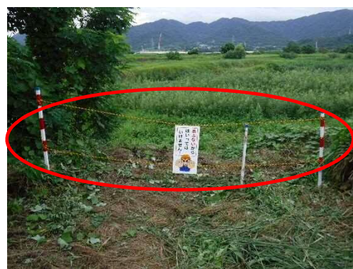
看板・ロープ設置
