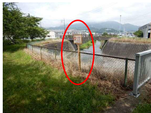
注意看板を設置
