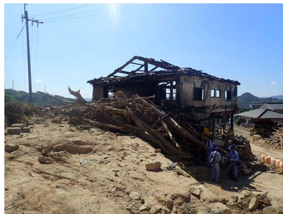
【砂防班】三原市内での被災状況調査
