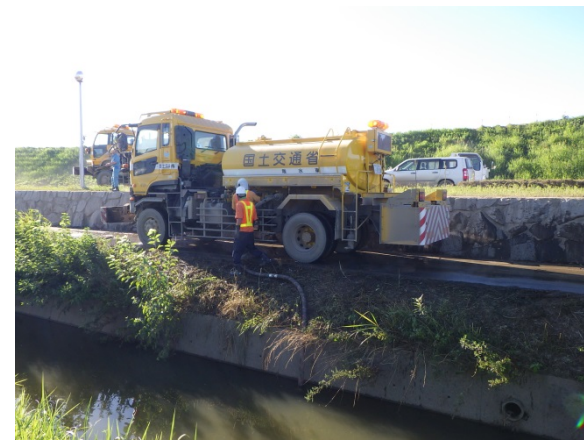
【応急対策班】倉敷市内での路面清掃作業
