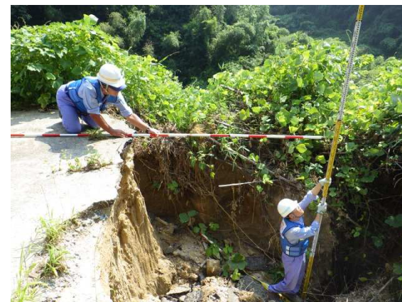
【道路班】東広島市内での被災状況調査
