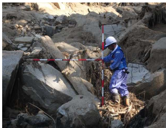
【砂防班】三原市内での被災状況調査
