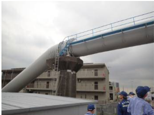
水管橋の検査状況
