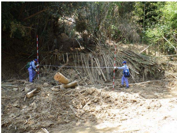
【道路班】宇和島市河内での被災状況調査
