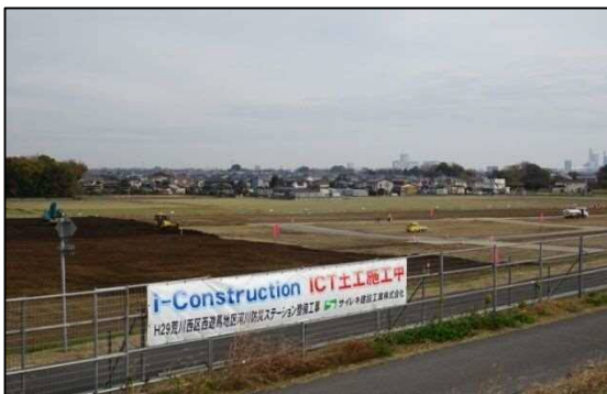
ICT土工により施工中であることをPR
