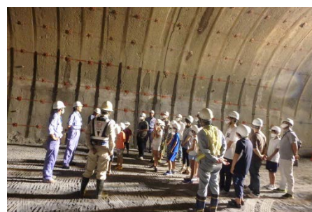
平成29年度見学会の様子 (上:コンクリート打設体験、下:トンネル見学)
