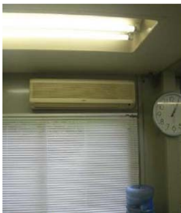
▲エアコン設置
