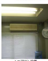
▲エアコン設置
