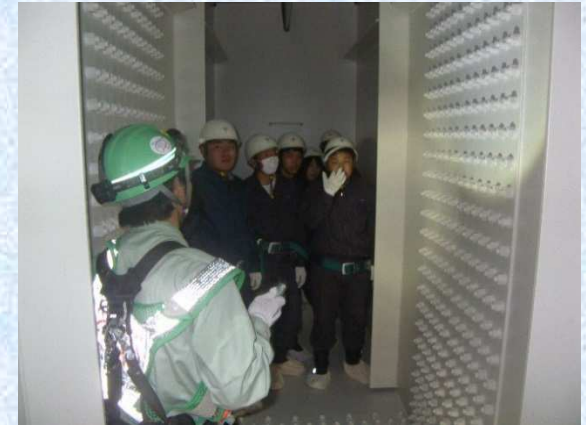
橋梁箱桁内の探検
