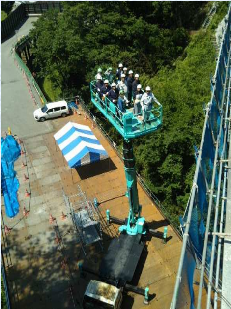
高所作業車の体験
