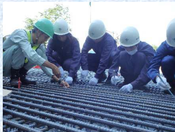
合成床版鉄筋の結束
