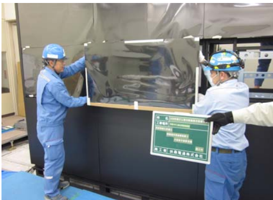
大型表示装置設置施工状況
