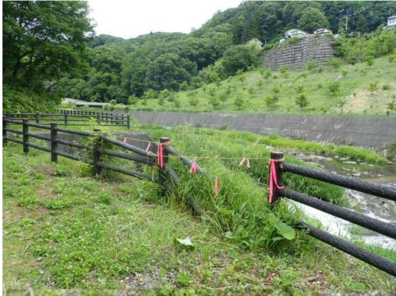
昨年度の台風により擬木柵が一部破損。立ち入り禁止や危険箇所をロープ等で応急措置を実施。
