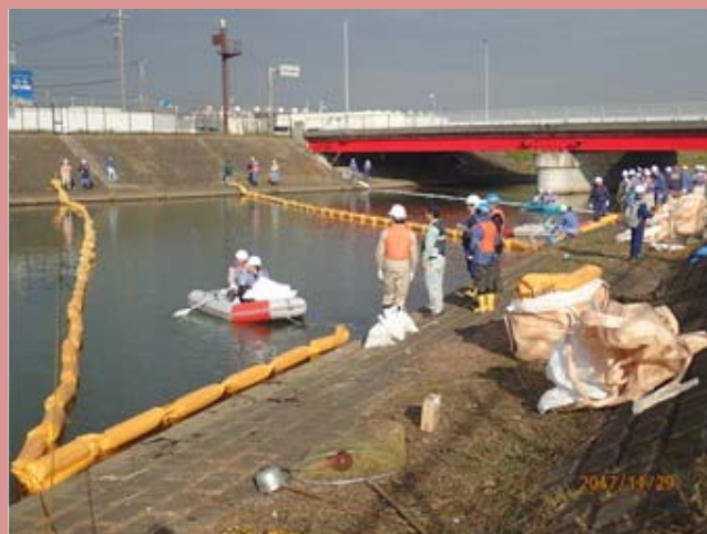
（オイルフェンス展張訓練）
