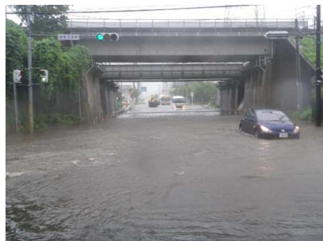
アンダーパス部 冠水時（平成28年7月豪雨時）
