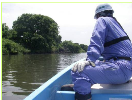
水上点検の実施状況
