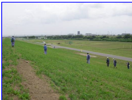
堤防点検の実施状況
