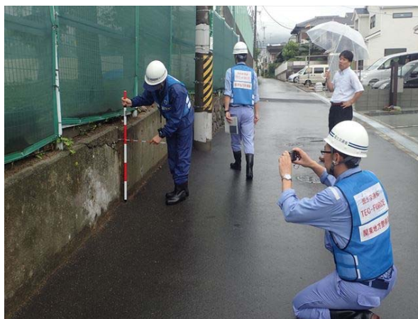
中学校の被害状況調査
