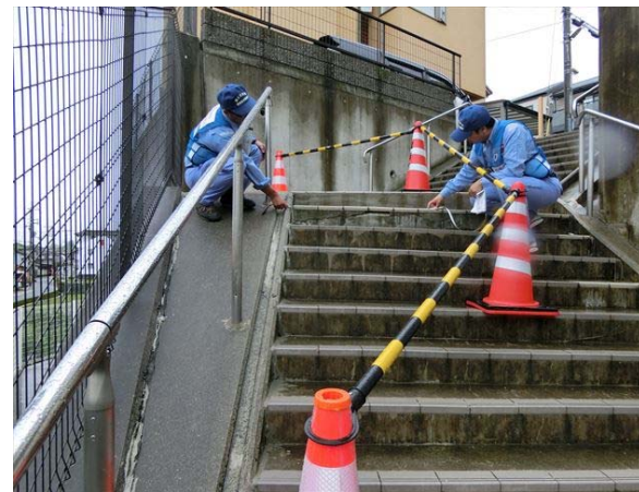
階段の被害状況調査
