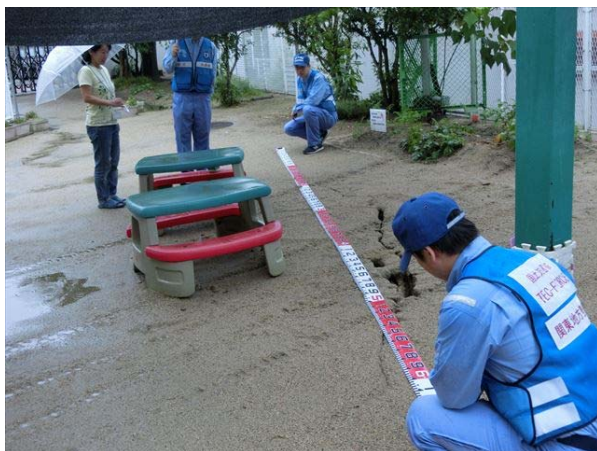
保育所の被害状況調査
