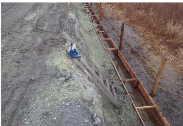
法面の昇降設備として脚立を立てかけて使用し、転位防止措置もなされていない
