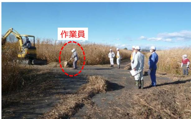
誘導員は配置しているが、作業員がバックホウの作業半径内に立ち入っている
