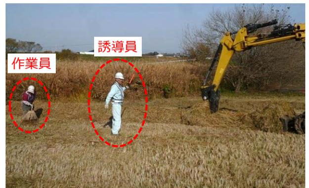
誘導員を配置したうえで、オペレーター及び作業員に対し、作業半径内に立ち入らないよう指導監督
