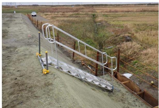
昇降用設備として仮設階段を設置
