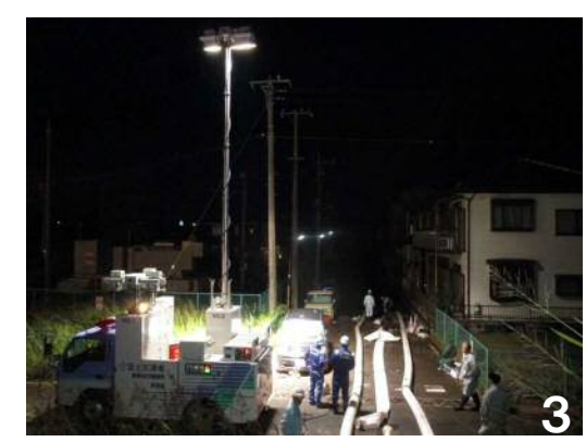
排水ポンプ稼働状況(川越市寺尾地区) 10月23日撮影
