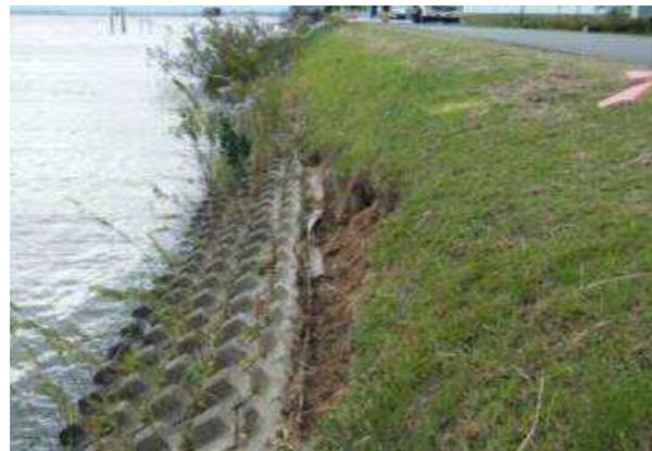
22日17:00から23日6:00にかけて、15m/sを超える強風(S~NE)が続き、高波浪により法面洗掘が約100m発生。
