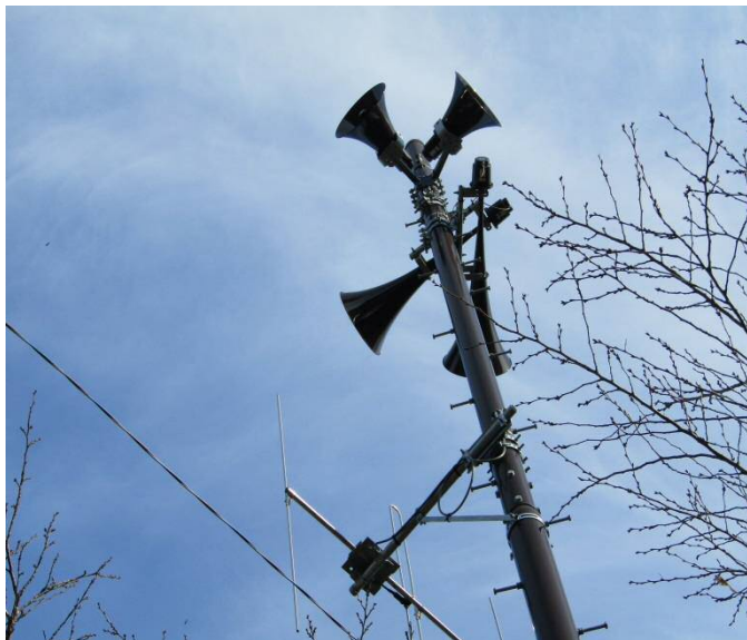
デジタル化更新した防災行政無線
