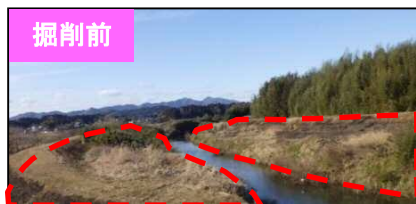
河道掘削による流下能力の向上
