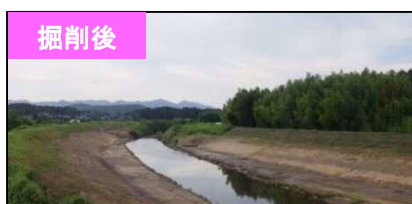
河道掘削による流下能力の向上
