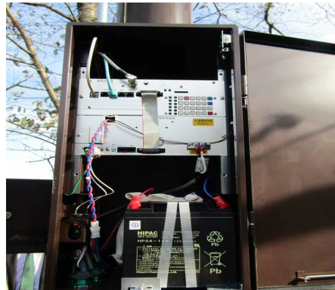
デジタル化更新した防災行政無線
