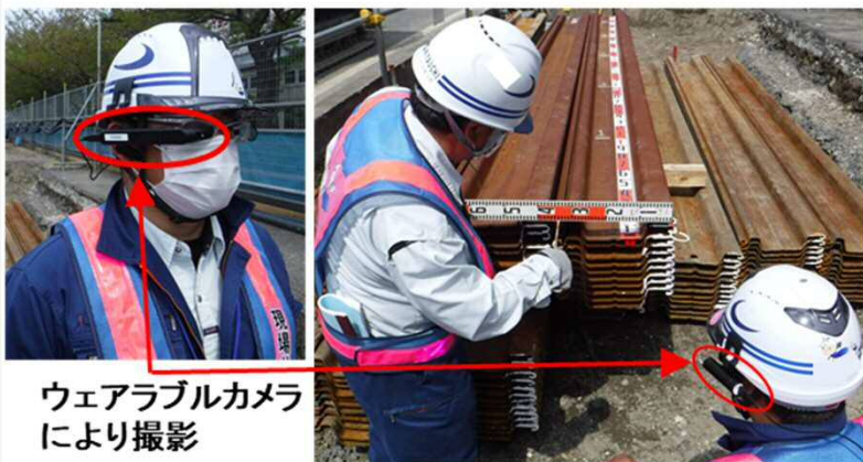
現場での受注者による撮影状況
