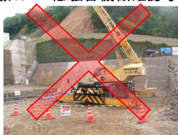
排ガス・低騒音機械確認写真
