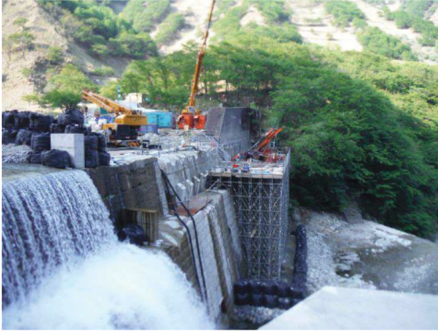
▲堤体の下流では10m以上の足場、上流では大型クレーンで資材の吊り上げ。さながら川の中でマンション建設の様？【5月15日】
