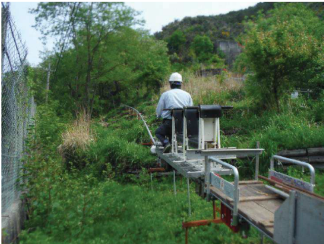
▲足尾砂防堰堤ゲート奥が施工区域ですが、この工事ではゲート手前より出発し、487mものモノレールを設置します。作業員の現場までの通勤手段として使用しますが、現場へ辿り着くにもこのように過酷なのです。【5月21日】
