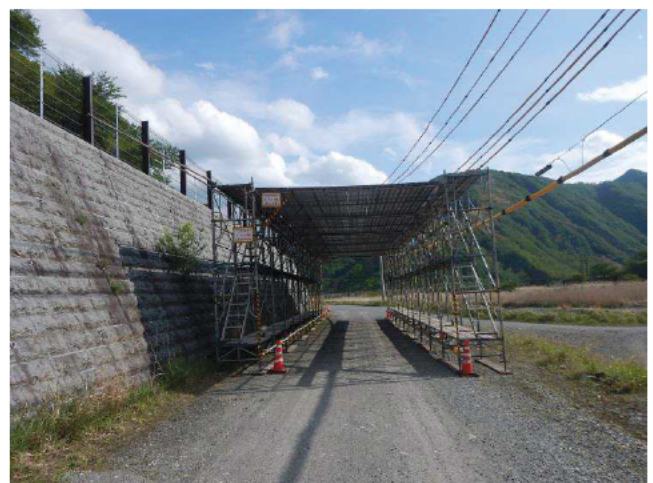
▲写真左手擁壁の向こう側が現場です。この屋根付きの仮設構造物は、上空を資材運搬用のケーブルクレーンが運転され、万が一資材等が落下し、車両等が損傷しないように防護の為に設置されたものです。【5月17日】
