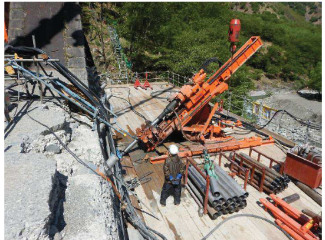
▲足場の上では、ボーリングマシーンにより二段ある内の下段のグラウンドアンカーを施工中です。【5月15日】
