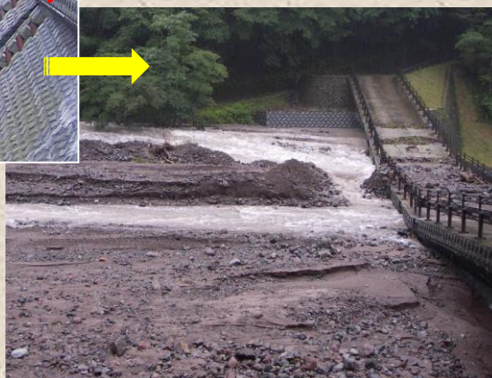
土石流発生後
