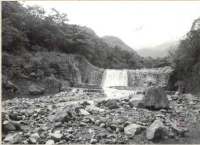
昭和39年に水路部などを補修
