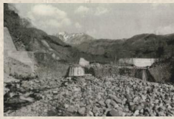
昭和40年9月の台風23号の出水で被害を吹け、護岸、擁壁の補修工事を実施
