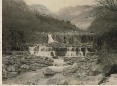
昭和9年、昭和23年に水通しを補修
