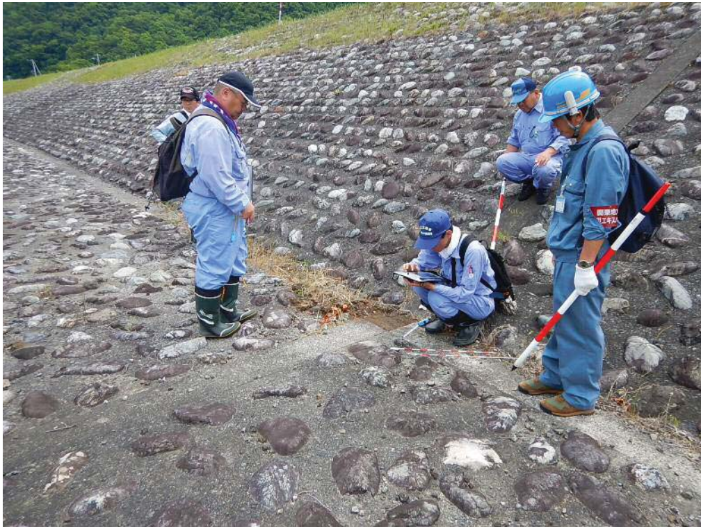
徒歩で堤防の状況を確認
