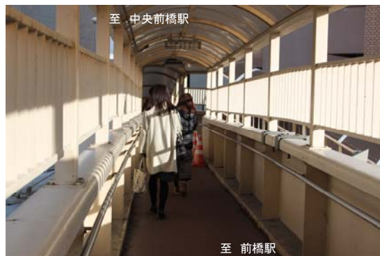
写真:前橋本町二丁目五差路の歩道橋
