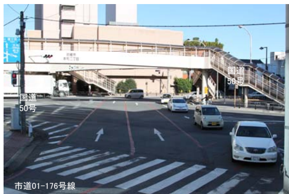
写真:前橋本町二丁目付近の現況
