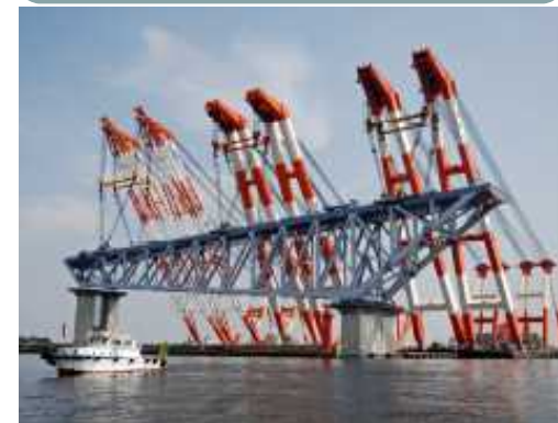
施工時の安全確保事例
