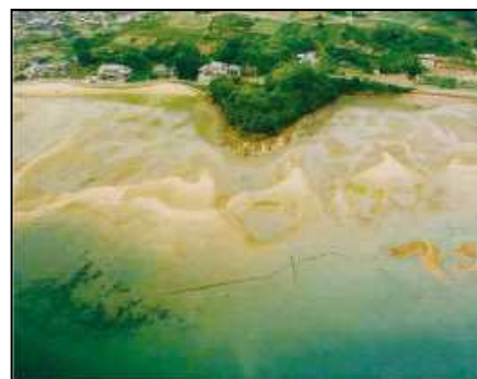
浚渫土を活用した干潟を造成
