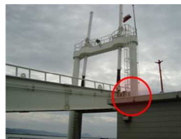
可動橋被災箇所
