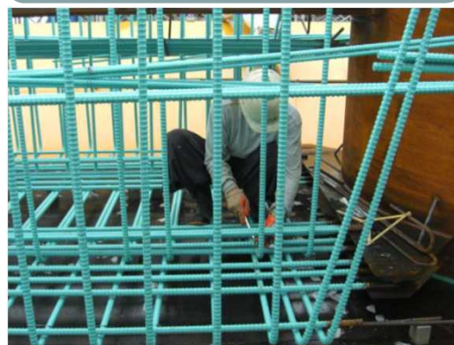
耐久性向上のためエポキシ樹脂塗装鉄筋を適用
