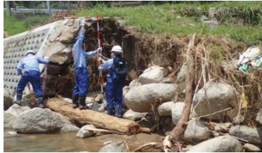
河川構造物の被害状況調査(添田町)
