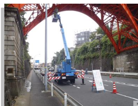
建設後 90 年以上が経つ震災復興橋梁の点検
