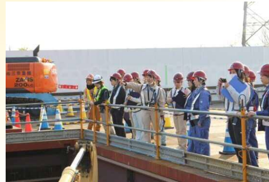
現場点検③
