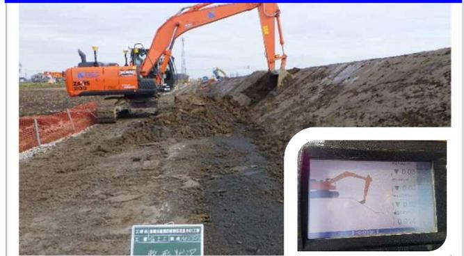
GNSSを用いた盛土の締固め管理状況
