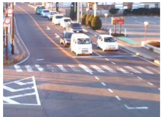
国道19号 高出交差点（長野県 塩尻市）
