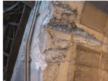
大型車による覆工の擦り状況
