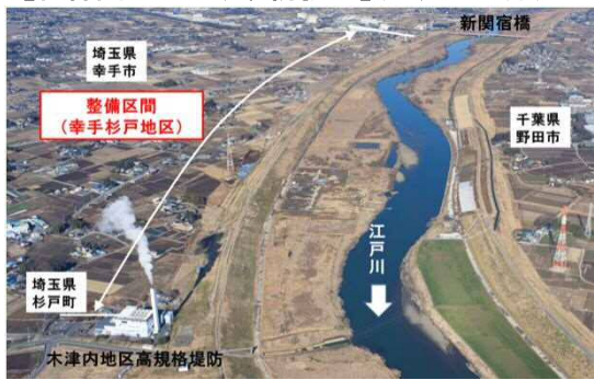
【首都圏氾濫区域堤防強化】(江戸川右岸)
