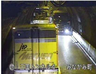
みくに 三国トンネル(現トンネル)の状況
