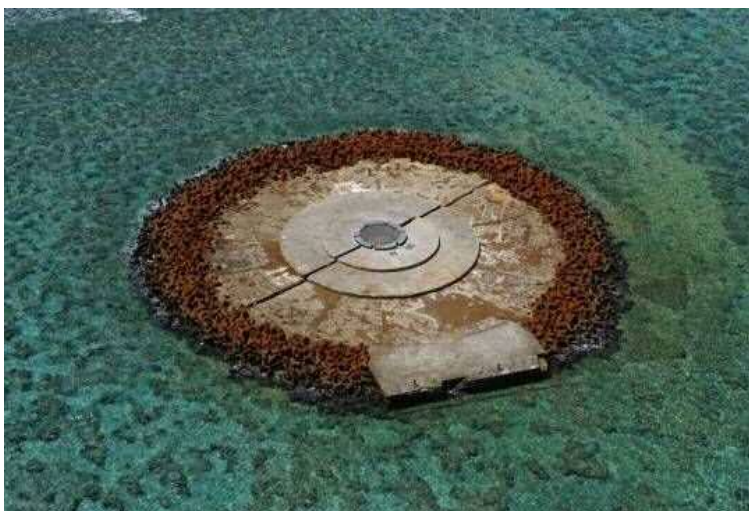
きたこじま 北小島護岸(平成19年)
