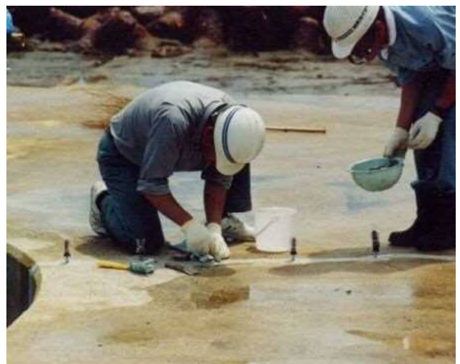
コンクリート護岸ひび割れ補修
