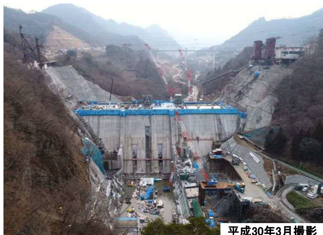
平成30年3月撮影 堤体打設状況
