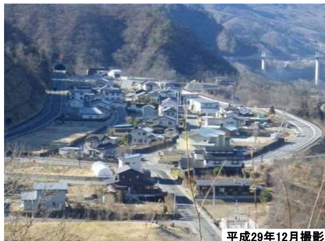
平成29年12月撮影 移転代替地(川原湯(打越)地区)
