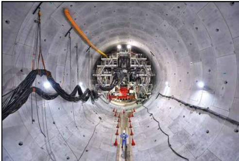
東名JCTシールドトンネル内の状況
