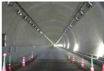
写真①:シールドトンネル内
