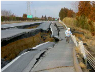
崩落した常磐自動車道 水戸IC～那珂IC付近 出典: 東日本高速道路(株)
