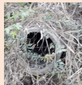
■ きぬ医師会病院駐車場付近の管
