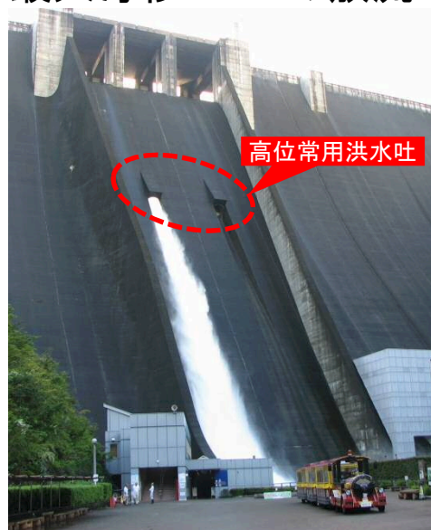
高位常用洪水吐2号ゲートによる 洪水調節の状況(毎秒65m 3 放流) [平成28年9月21日台風16号]
