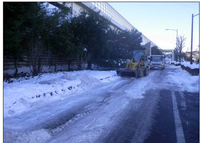
国道298号側道の除雪作業状況（1/23）
