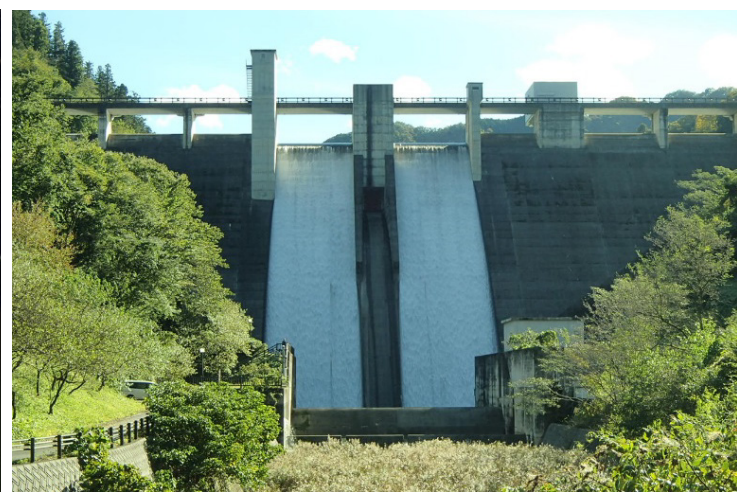
洪水吐から越流している様子
