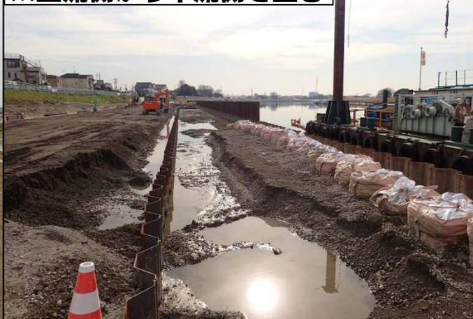
新しく河川敷(平場部分)を確保するため、中川に鋼矢板を打設し、矢板内側の水面だったところに砕石を敷均しました。この後、低水護岸としての施設整備を行うとともに、砕石上部には盛土を実施して工事が完成します。
