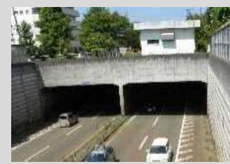
大型ボックスカルバート
