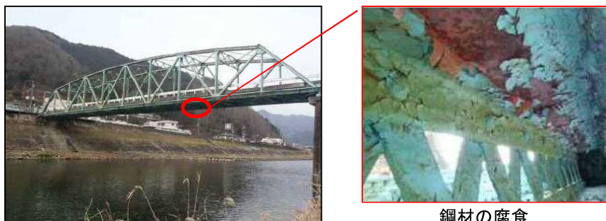
鋼材の腐食
