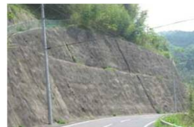
モルタル吹付
