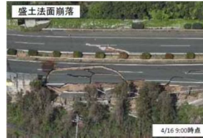
九州自動車道 益城町
