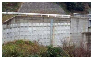
盛土（補強土壁）
