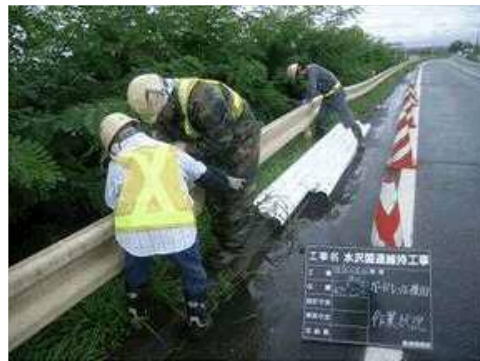
<防護柵の取替>
