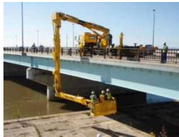
橋梁点検車による点検
