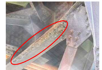
耐候性鋼材に層状の剥離
