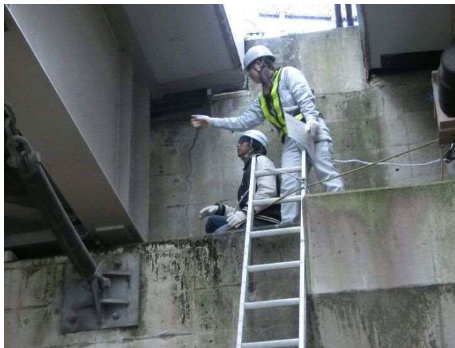
伸縮装置等の近接目視体験
