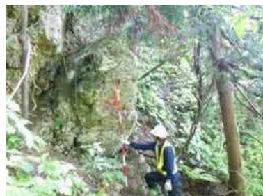
(危険度調査状況)
