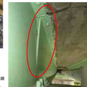
主桁の変形
