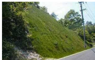
切土（のり面保護）
