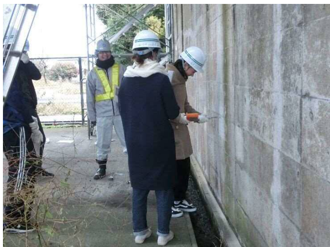
橋台部にてコンクリート強度確認体験
