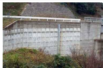
盛土(補強土壁)
