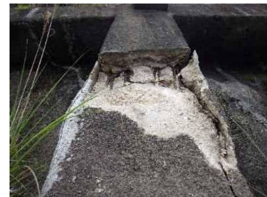
法枠工の老朽化損傷
