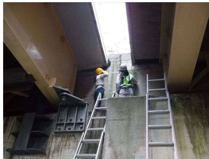
伸縮装置等の近接目視体験
