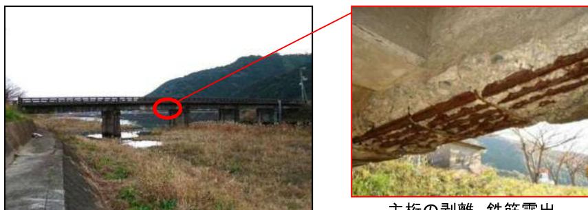
主桁の剥離、鉄筋露出
