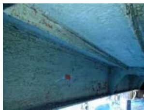
桁の塗装劣化やさびの発生
