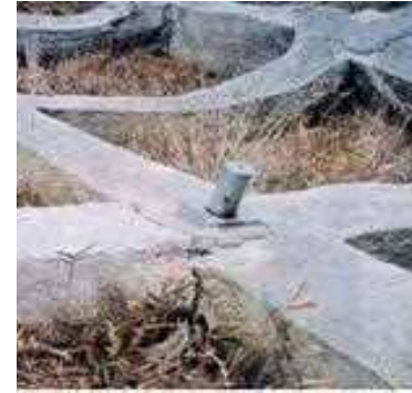
写真 受圧構造物の破損の例
