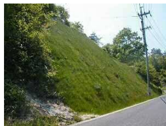
切土(法面保護)
