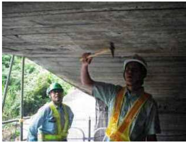
目視及びハンマーによる打音検査
