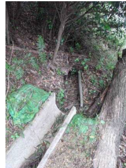
写真 排水溝の破損の例
