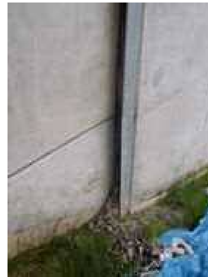
写真 土砂のこぼれ出し例
