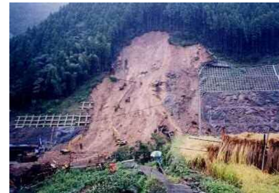
強風化・土砂化斜面での崩壊例
