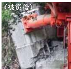
制震ダンパー取付部の損傷
