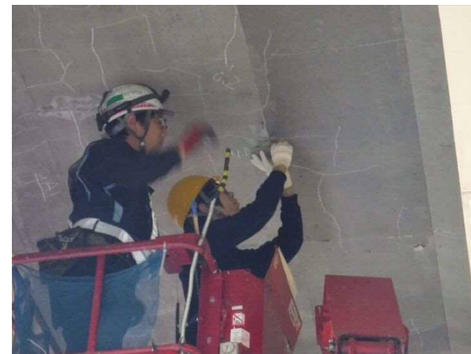
高所作業車で床版のびび割れ計測体験
