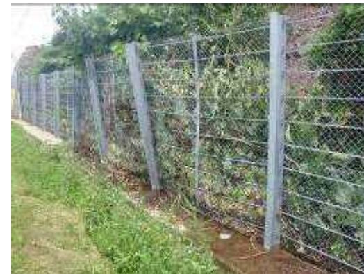
写真 落石防護柵の傾動の例
